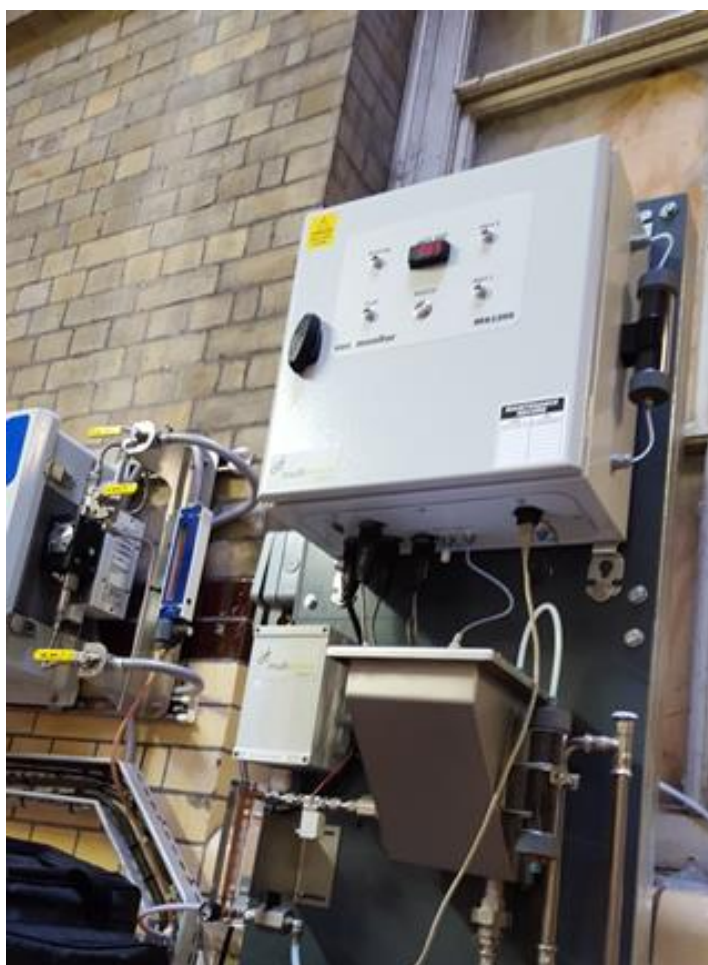
Figure 18 - Installation du MS1200 en 2014
