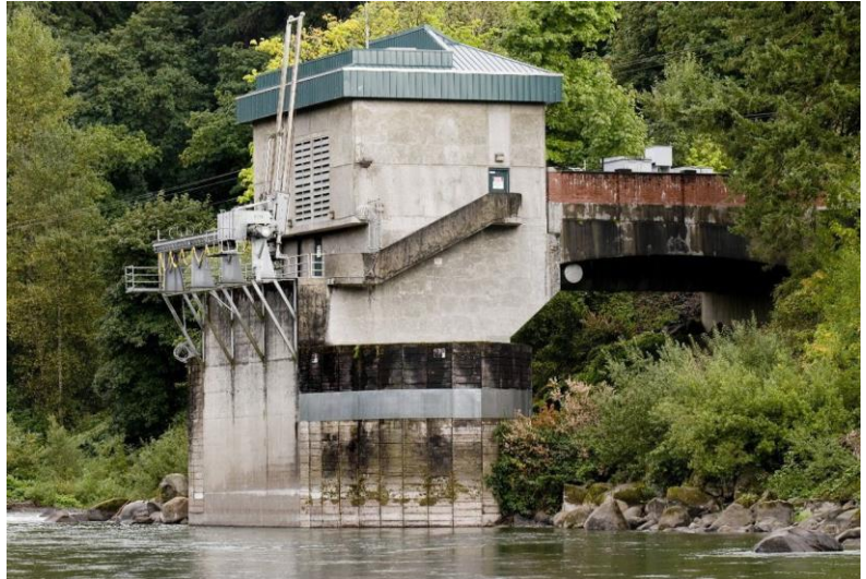
Figure 1 - Une prise d'eau de rivière
